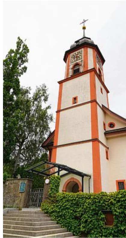
Die Sankt Nikolauskirche in Krenkingen wurde 1766 errichtet.
