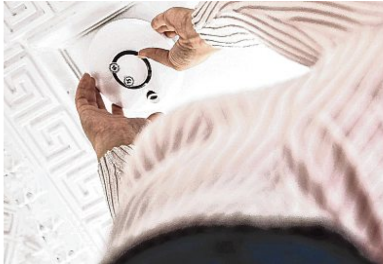
Rauchmelder können Eigentümer recht einfach selbst installieren. Einmal im Jahr sollte man die Funktionsfähigkeit überprüfen. BILD: CHRISTIN KLOSE/DPA
